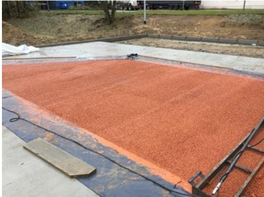
Abbildung 1 Betonage des Parkplatz
