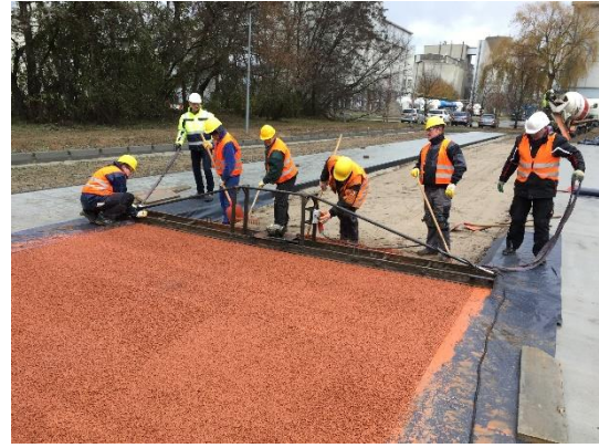
Abbildung 2 Einsatz der Rüttelbohle
