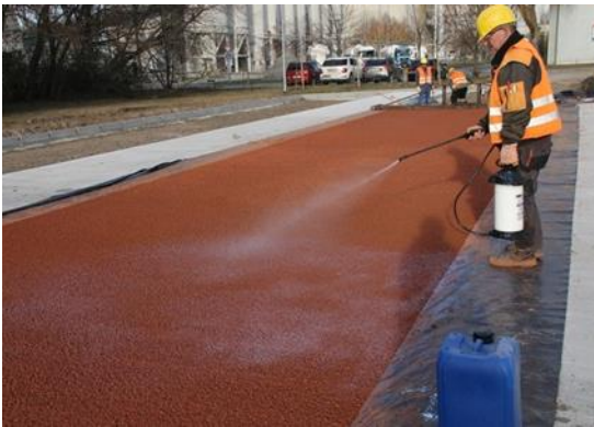
Abbildung 3 Nachbehandlung der Dränbetonfläche
