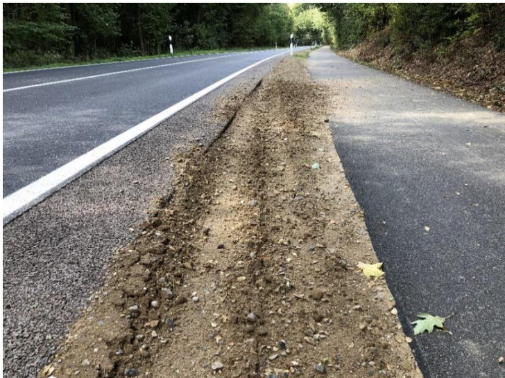
Abbildung 1 - unbefestigtes Bankett
