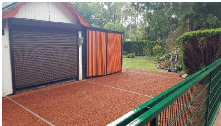
Abbildung 1 Parkplatzfläche aus Dränbeton
