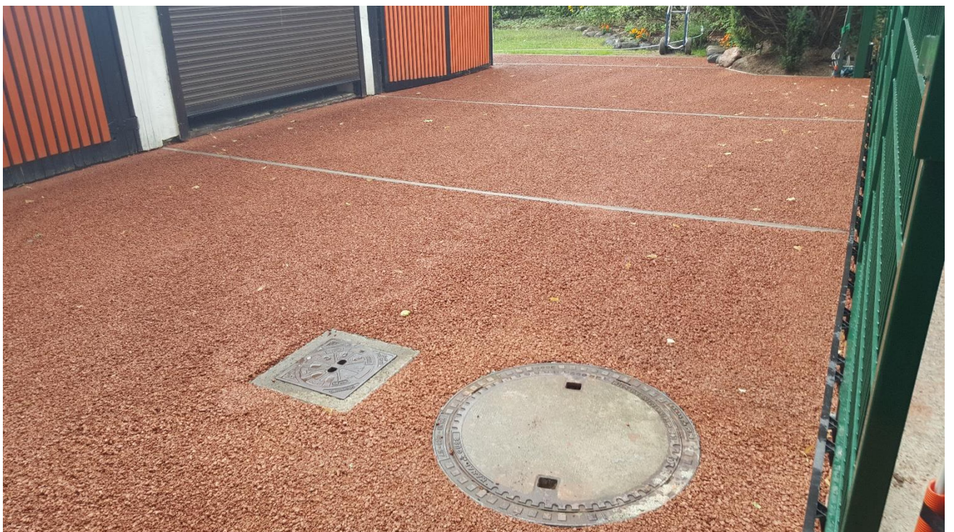
Abbildung 3 Parkfläche aus Dränbeton
