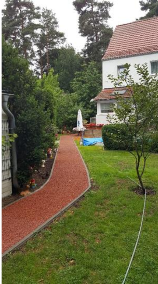
Abbildung 2 Gartenweg aus Dränbeton
