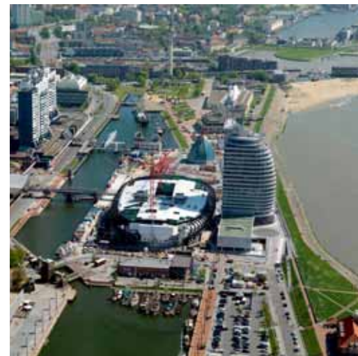
Die Baustelle des Klimahauses Bremerhaven im Mai 2008. Rechts vom Klimahaus das Atlantic Hotel SailCity.
