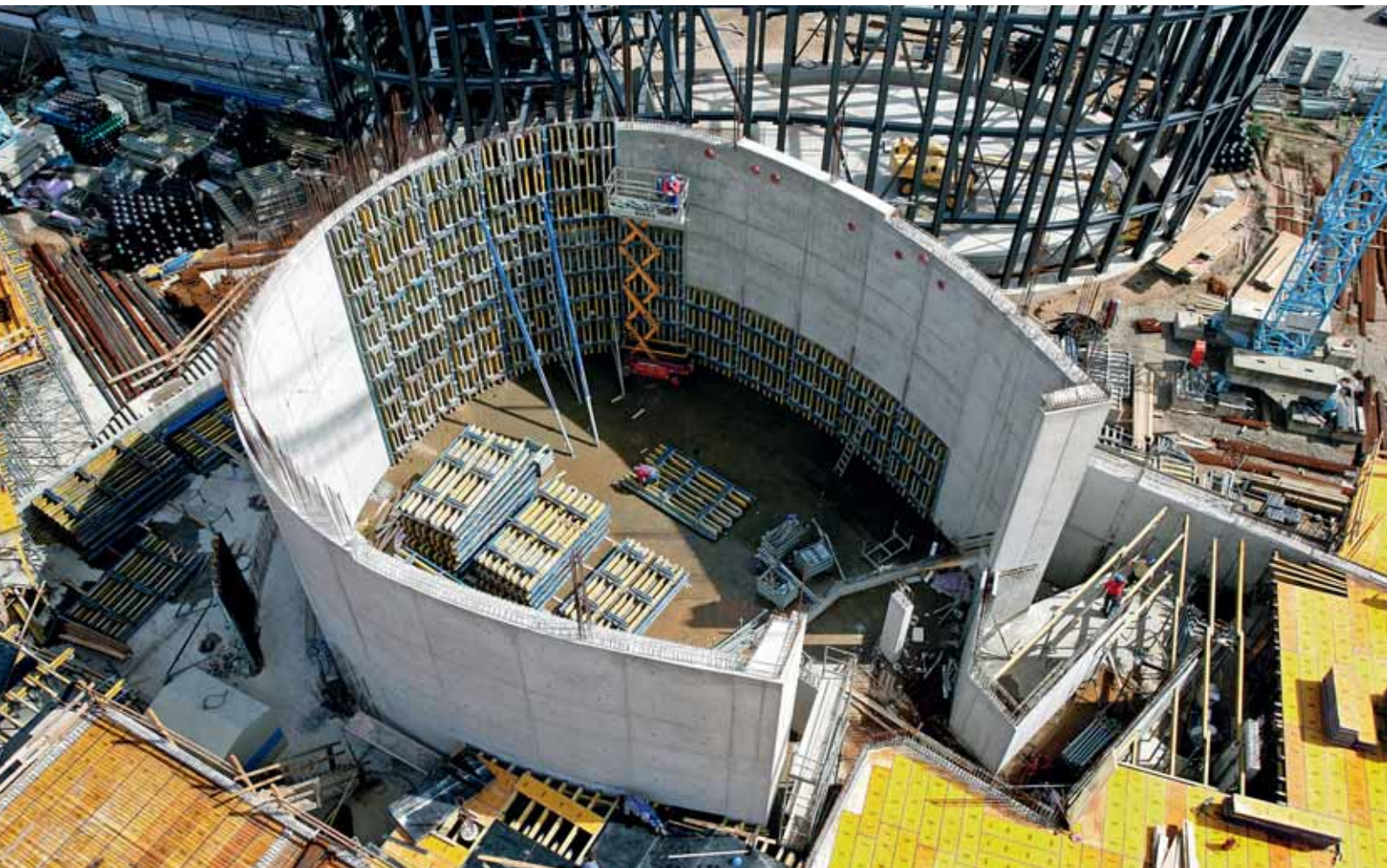
Der Rohbau des Schwarmfischbeckens
