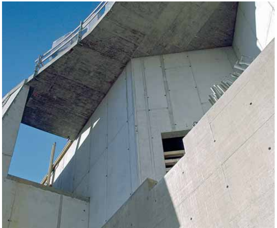
Rechte Winkel sind an den Außenwänden des Ozeaneums selten zu finden. (Seiteneingang zur Nordseeausstellung)
