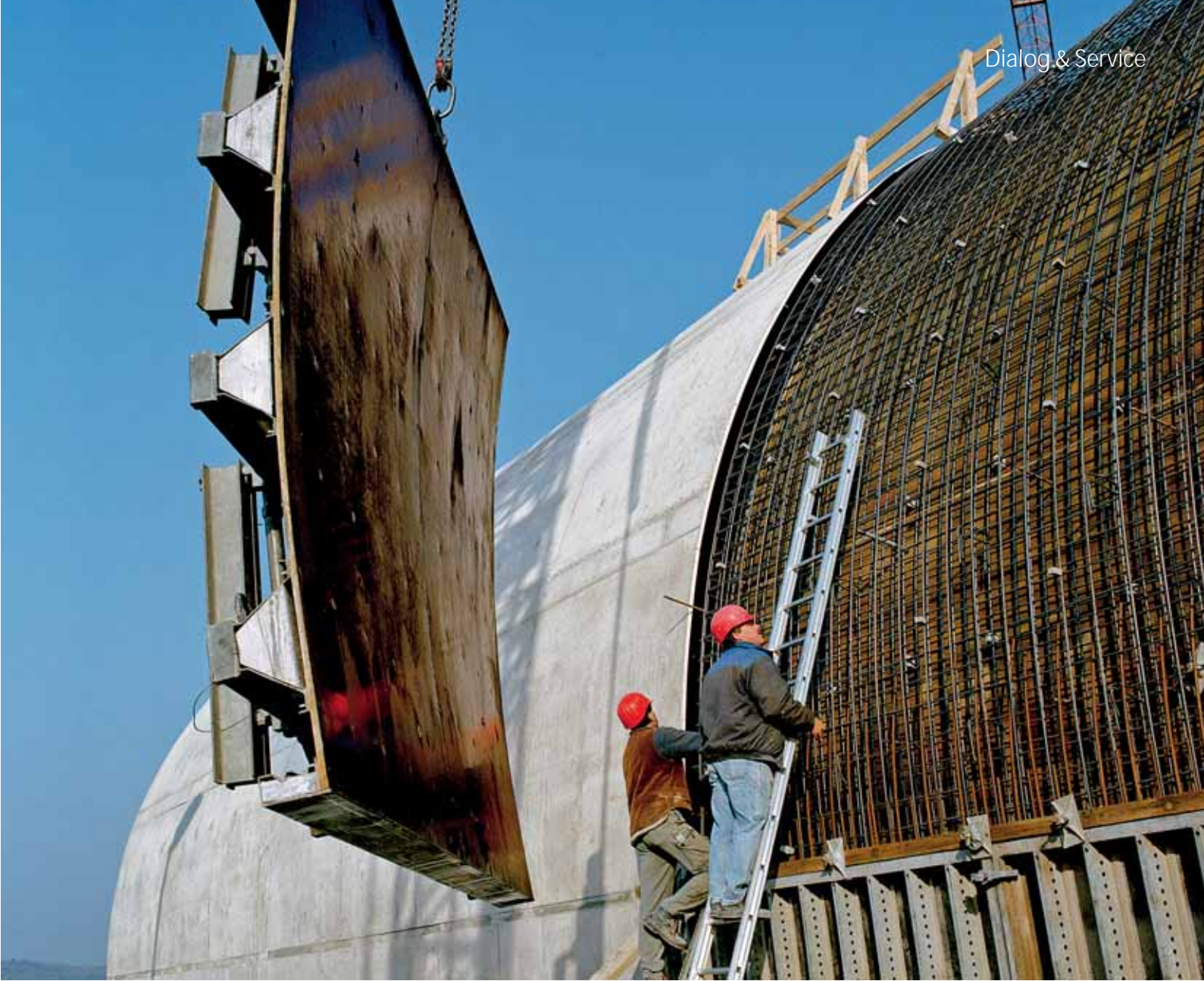
Montage der Hünnebeck-Rundschalung RONDA mit einem Schwerlastkran
