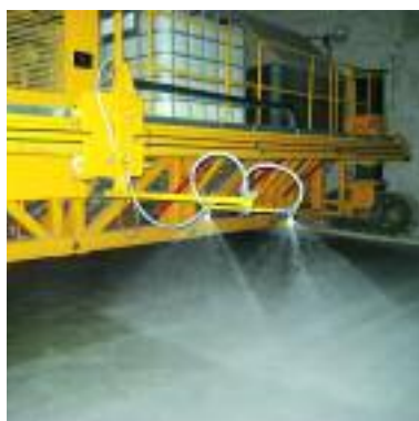
Gleichmäßiger Auftrag des Oberflächenverzögerers ist eine Voraussetzung für gute Qualität der Waschbetontextur.
