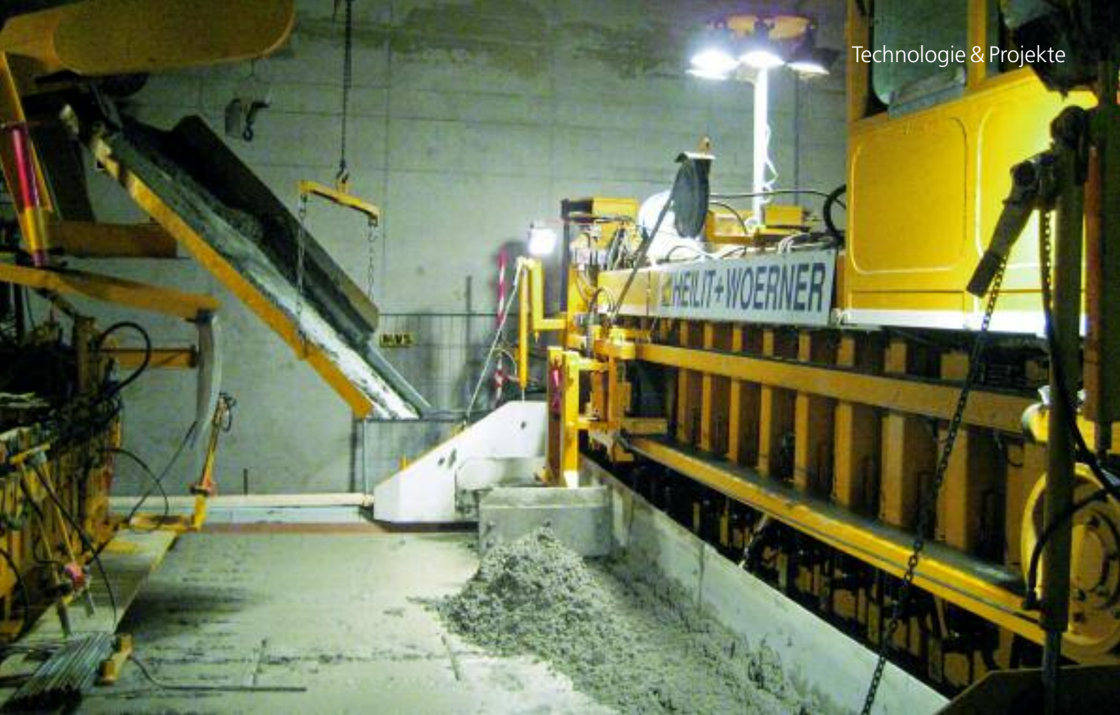
Einbau und Verdichtung des Oberbetons auf dem noch frischen Unterbeton mit dem Gleitschalungsfertiger
