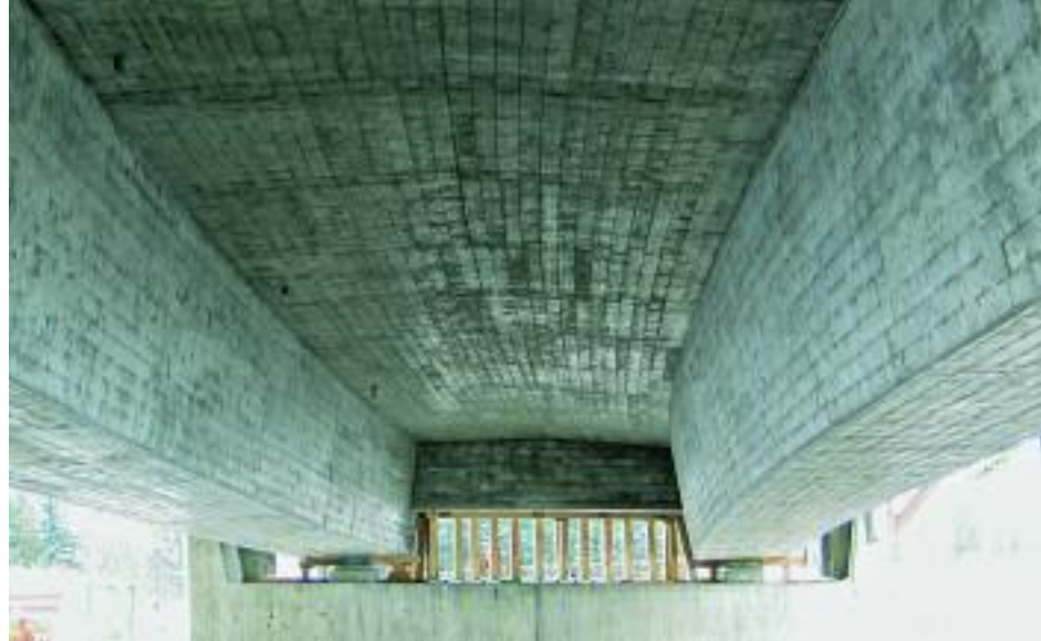
Brücke auf Widerlagern über dem Fluss Wertach im Unterallgäu, gebaut mit aaton basic®
