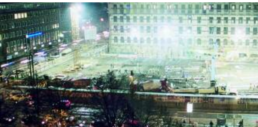
Auch auf dieser Baustelle am Graf-Adolf-Platz in Düsseldorf herrscht große Enge.
