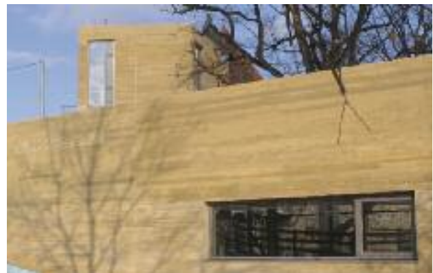
Bruchstein trifft Sichtbeton: Die Erweiterungsbauten der mittelalterlichen Lukasklausur Magdeburg bestehen aus eingefärbtem leichtverdichtbarem Beton.
