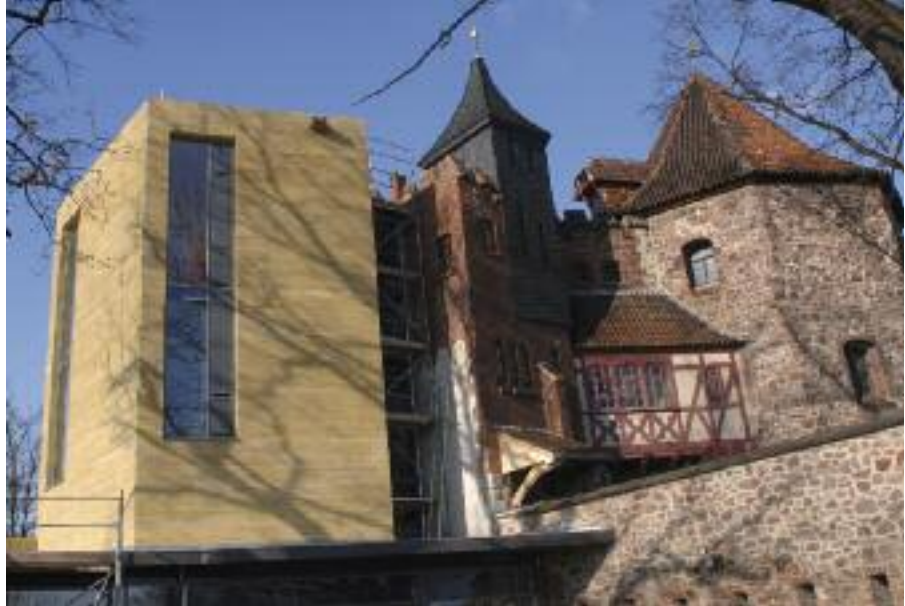
Bruchstein trifft Sichtbeton: Die Erweiterungsbauten der mittelalterlichen Lukasklausur Magdeburg bestehen aus eingefärbtem leichtverdichtbarem Beton.
