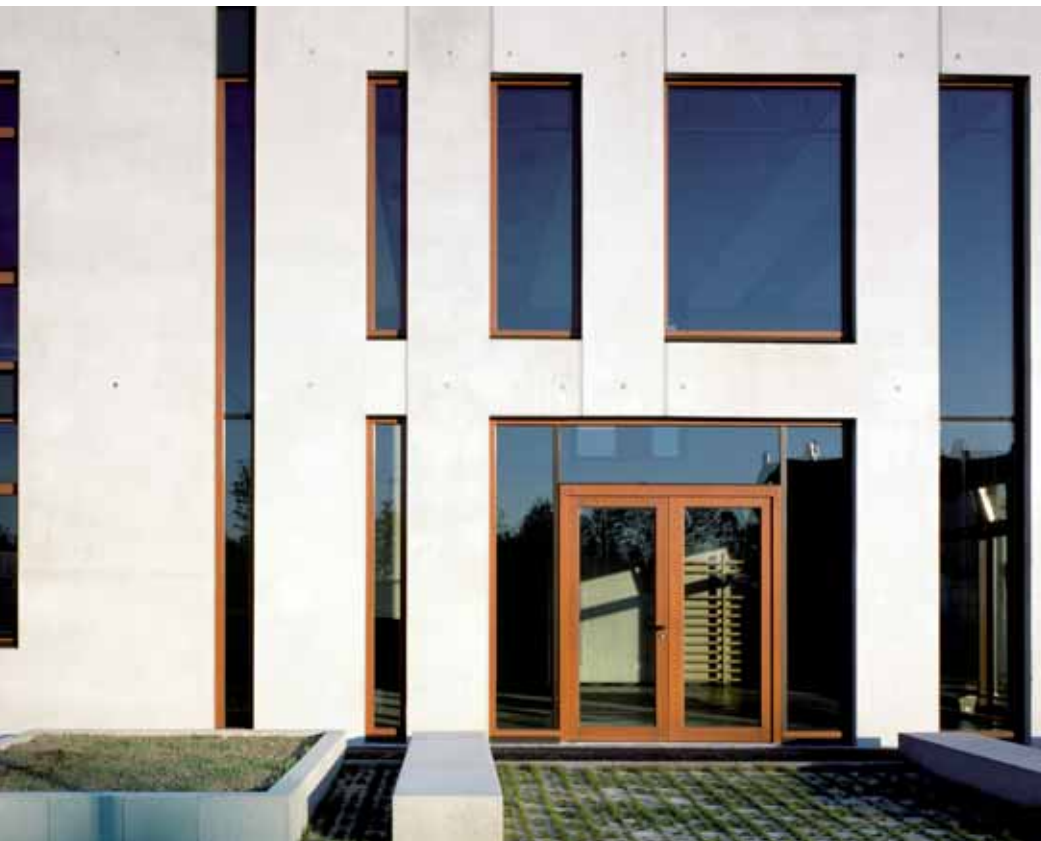
Schule Pfeuferstraße, München: Ihre markante Gebäudehülle besteht aus einem selbstverdichtenden Beton C 30/37, Konsistenzklasse F6. Ein Portlandkalksteinzement trägt zum hellen Farbton der Betonoberfläche bei.
