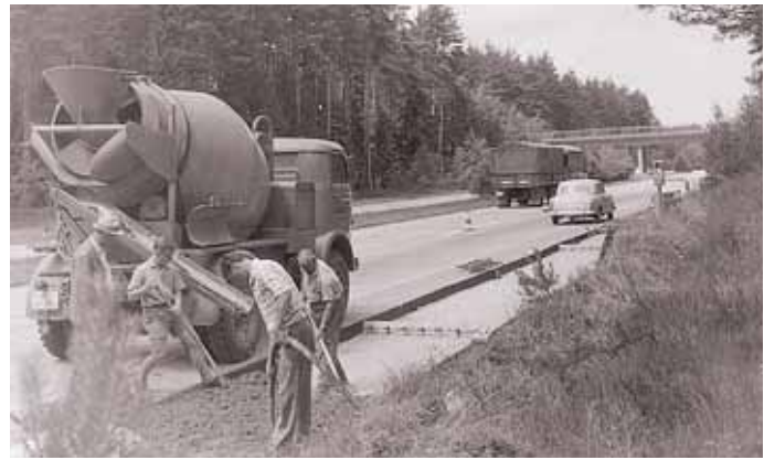
oben _ Nürnberg 1961: einer von vier 3,5-m 3 -Fahrmischern der Mixbeton GmbH bei einer der ersten Lieferungen
