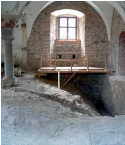
links _ Schloss Friedrichsburg vor der Sanierung: Blick auf das freigelegte Tonnengewölbe rechts _ Nach der Verfüllung: das Erdgeschoss mit neuem Fußboden
